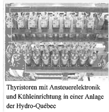
Innenraum einer Stromrichteranlage mit Hochspannungsgleichrichter. Während des Betriebs kann der Raum wegen der Gefahr von Gasentladungen nicht betreten werden.
